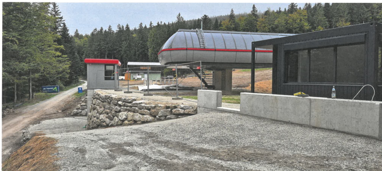
Talstation der kuppelbaren 6er-Sesselbahn knapp vor der Fertigstellung
