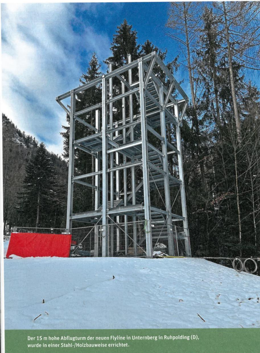
Der 15 m hohe Abflurgturm der neuen Flyline in Unternberg in Ruhpolding (D), wurde in einer Stahl-/Holzbauweise errichtet.
