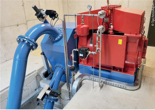
Zuverlässig und leistungsstark: Die 2-düsige Pelton-turbine vom Südtiroler Wasserkraftspezialisten Sora ist auf eine Netto-Fallhöhe von 166 m und einen Durchfluss von 250 l/s ausgelegt - und kommt dabei auf 380 kW.
