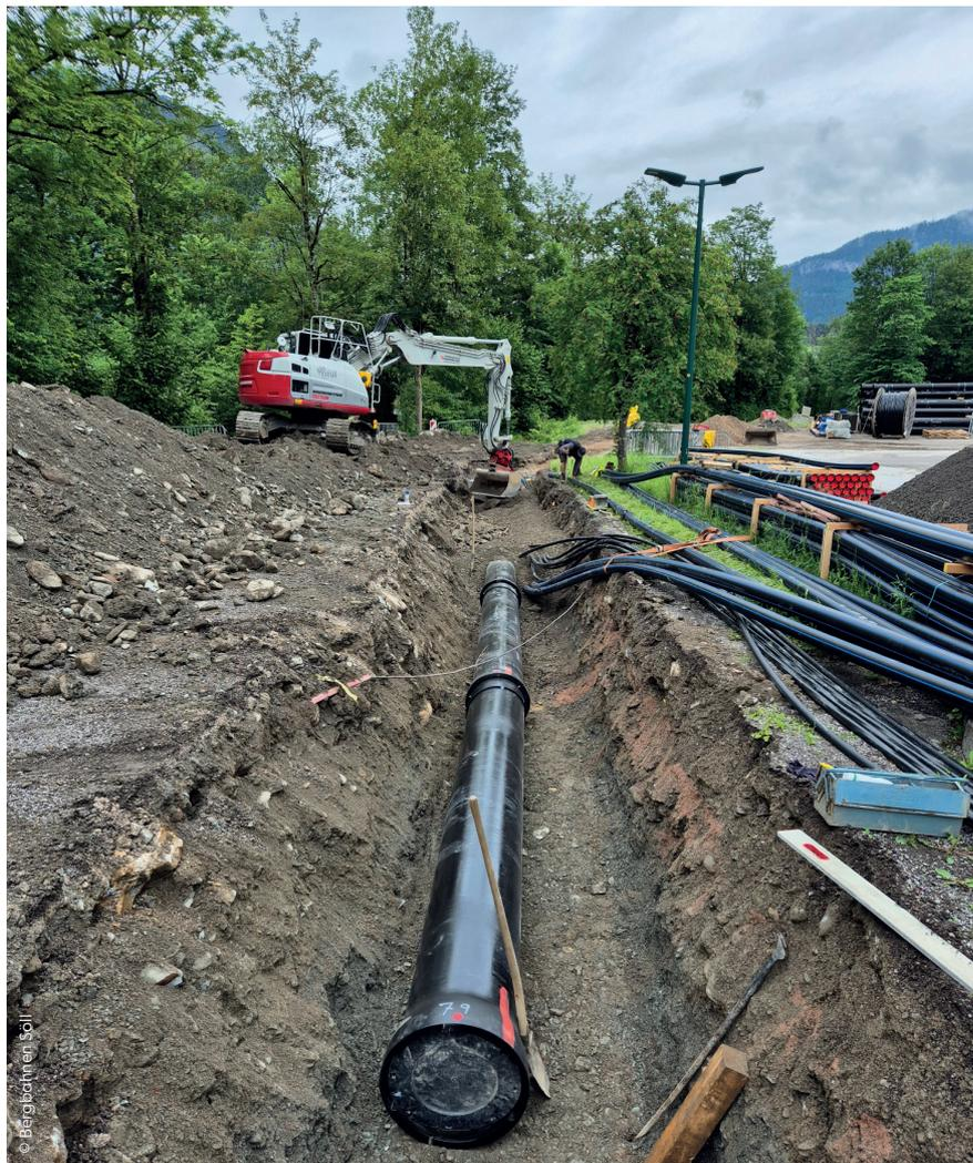
Über eine Gesamtlänge von 2,5 km wurden Gussrohre von TRM (DN400/DN500) verlegt. Sie garantieren eine wirtschaftliche Verlegung und eine hohe Standfestigkeit.
