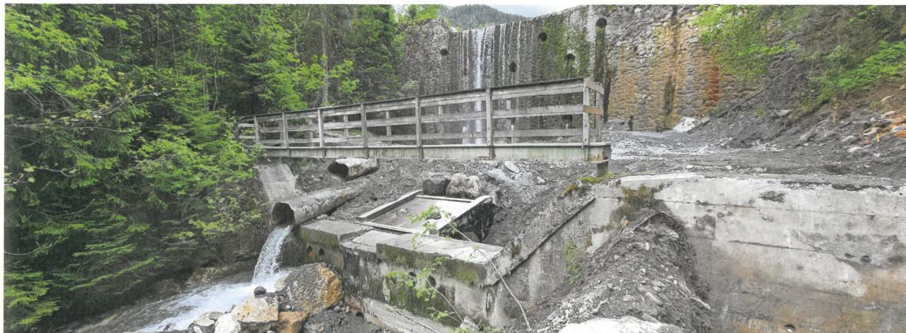
Klenkhart & Partner konzipierten das Kleinwasserkraftwerk Stampfangerbach in Form eines Ausleitungskraftwerkes, das zirka ein Viertel der benötigten Jahresenergie abgedeckt.
