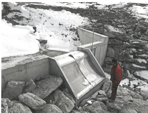
Wasserfassung mit Überlauf des Kraftwerks Isse
