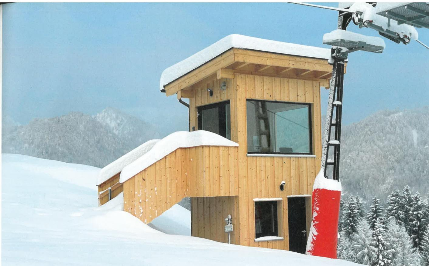
Die renovierte Bergstation des Fis-Liftes wurde mit einem Obergeschoss ausgestattet und in Holzriegelbau errichtet. Foto: KLENKHART
