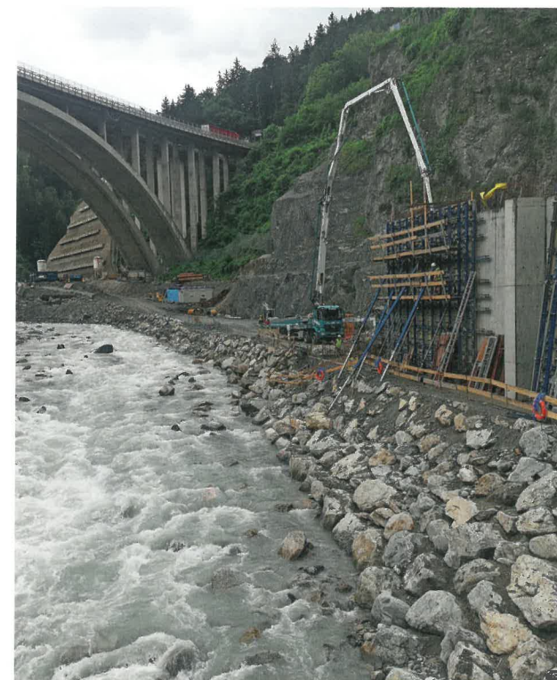
Die von Klenkhart & Partner geplante Fischrampe in der Sillschlucht bei Innsbruck: Die Stützmauer für die Bahnstrecke befindet sich noch im Bau.
