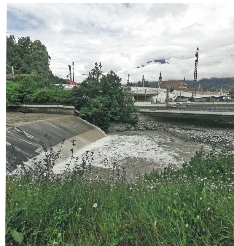
Das AGA-Wehr in der Sillschlucht vor dem Umbau.
