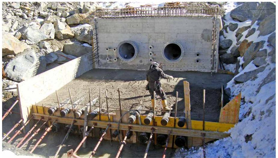
*Ende des Rohrtunnels - Anschluss Speicherteich.*
