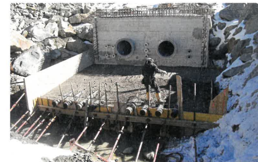
Stubai Gletscher Ende des Rohrtunnels und Anschluss Speicherteich.
