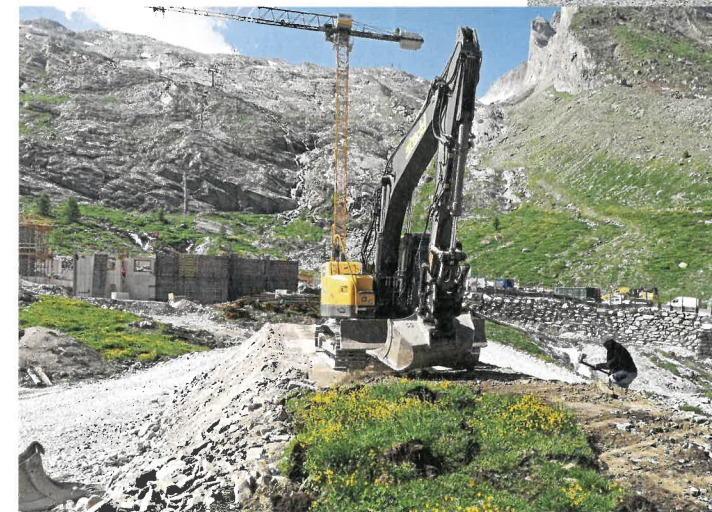
Der Speicherteich Hartkaiser in Ellmau wurde erneuert sowie das Speichervolumen von bisher 82.000m³ auf 140.000m³ vergrößert.
