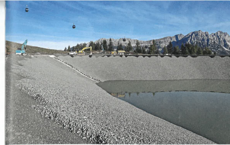
Der Speicherteich Hartkaiser in Ellmau wurde erneuert sowie das Speichervolumen von bisher 82.000m³ auf 140.000m³ vergrößert.
