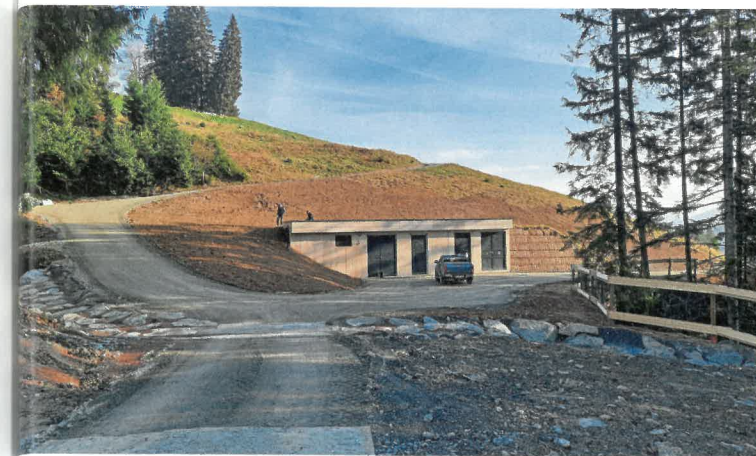
Schieberkammer und Trafostation sind perfekt in die Umgebung integriert.
