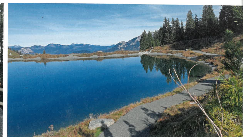
Der Speicherteich Tanzboden wurde ebenfalls um ca. 35.000 m 3 vergrößert.
