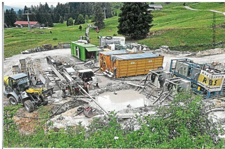
Startgrube der Horizontalbohrung bei der Kotalm mit Bohrgerät, Spülings-aufbereitung, Entsandungs- und Absetzanlage.
