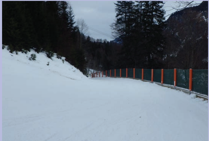
Einfahrt Winter NACH Umsetzung der Maßnahmen
