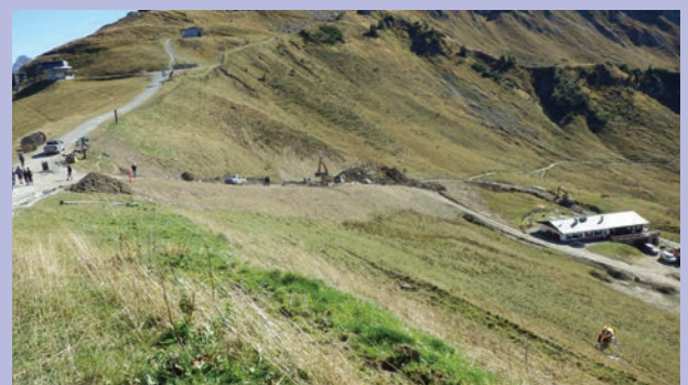
MITTEN in der Baumaßnahme
