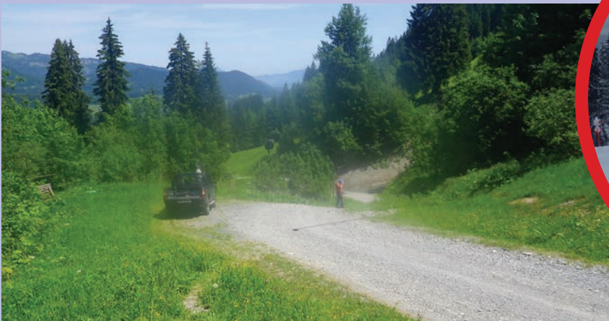
Talabfahrt VOR Beginn der Maßnahme im Sommer
