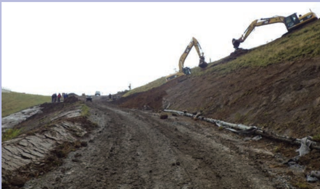
MITTEN in der Baumaßnahme
