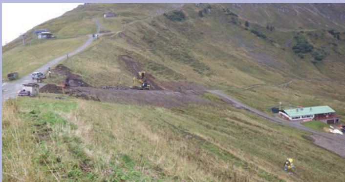
AM Beginn der Baumaßnahme
