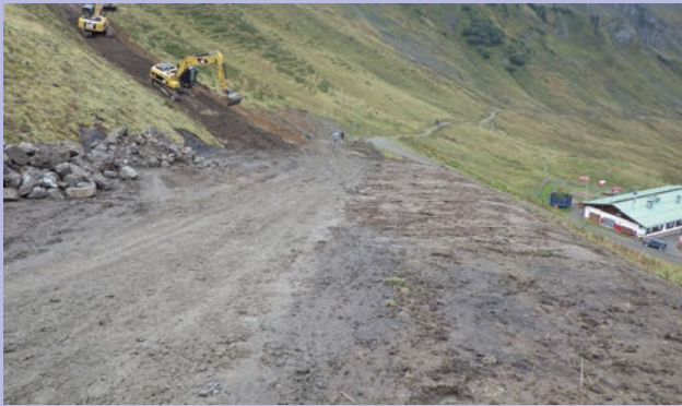
MITTEN in der Baumaßnahme
