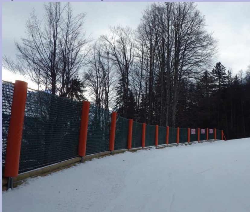
Engstelle Winter NACH Umsetzung der Maßnahmen
