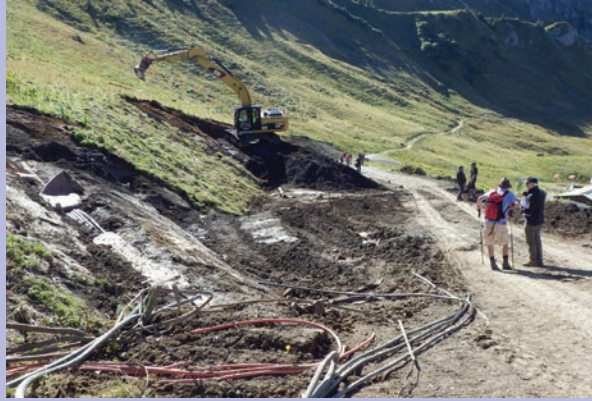
AM Beginn der Baumaßnahme
