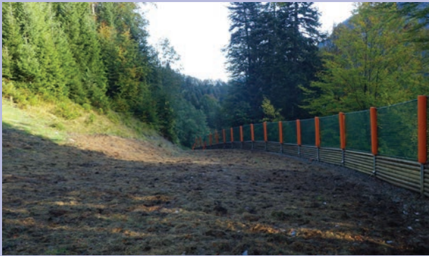
Einfahrt Herbst NACH Umsetzung der Maßnahmen
