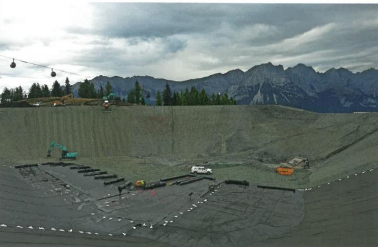
Aufbringen der Dichtungsbahnen am Speicherteich *Hartkaiser* im Skigebiet Wilder Kaiser. Der neue Speicherteich *Hartkaiser* verfügt nun über ein Fassungsvermögen von 140.000 m<sup>3</sup>, er wurde an der Stelle eines bestehenden Speicherteichs komplett neu errichtet.
