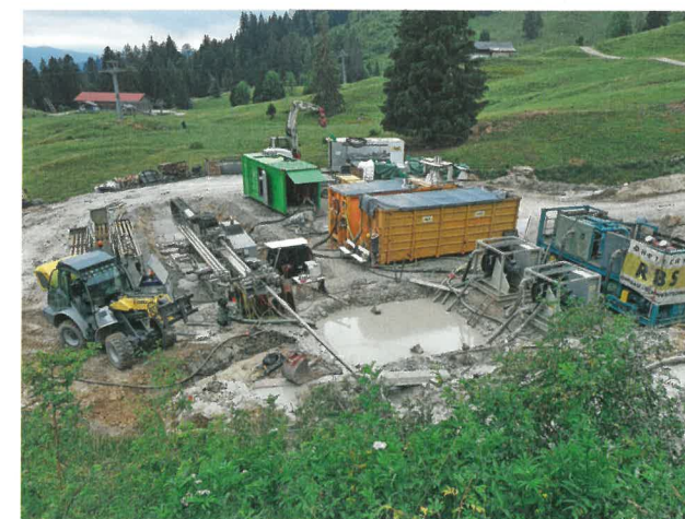
Bauarbeiten bei der Startgrube im Bereich der Kotalm
