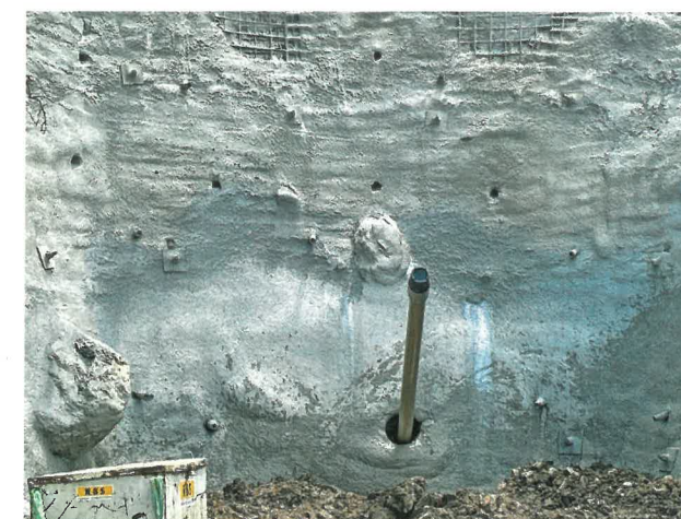
Bohrkopf bei der Startgrube
