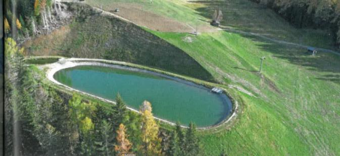
Der Speicherteich *Kartitsch* in Osttirol dient auch als Retentionsbecken. Um Wassermassen bei Gewittern aufzunehmen, wird der Wasserspiegel im Sommer auf rund einem Meter unter dem Stauziel gehalten.
