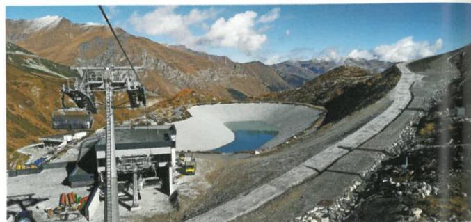
Das Herzstück der erweiterten Beschneigungsanlage am Hintertuxer Gletscher bildet der neue, rund 77.000 m<sup>3</sup> fassende Speicherteich *Keesboden* auf 2.100 m Seehöhe.
