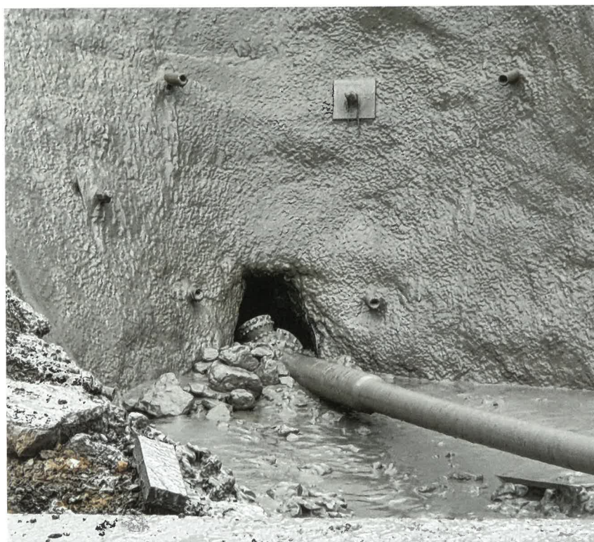
Durch eine innovative Lösung zur Umverteilung des Schneiwassers zwischen den Skigebieten konnte auf den Bau eines weiteren Schneiteichs verzichtet werden.
