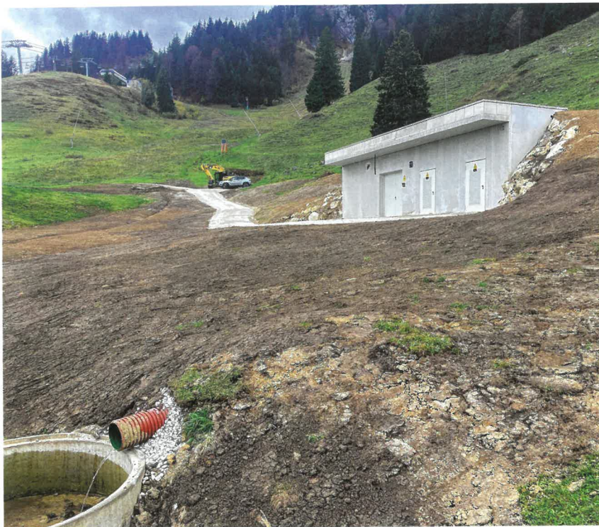
An der Druckerrhöhungsstation Kotalm ist für die Beschneigung des Bereichs Finstermünz nur eine sehr geringe Druckerhöhung notwendig.
