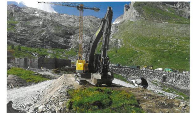
Der Beton wurde vor Ort hergestellt. Ebenso der Betonzuschlag, der aus dem Aushubmaterial des Speicherteichs stammt.
