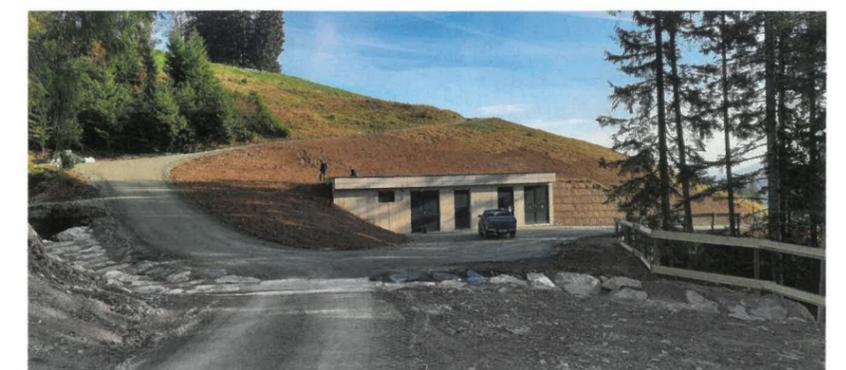
In der Pumpstation für den Speicherteich Hartkaiser ist Platz für das Lager, zwei Pistengeräte, Elektroräume und die Trafostation.
